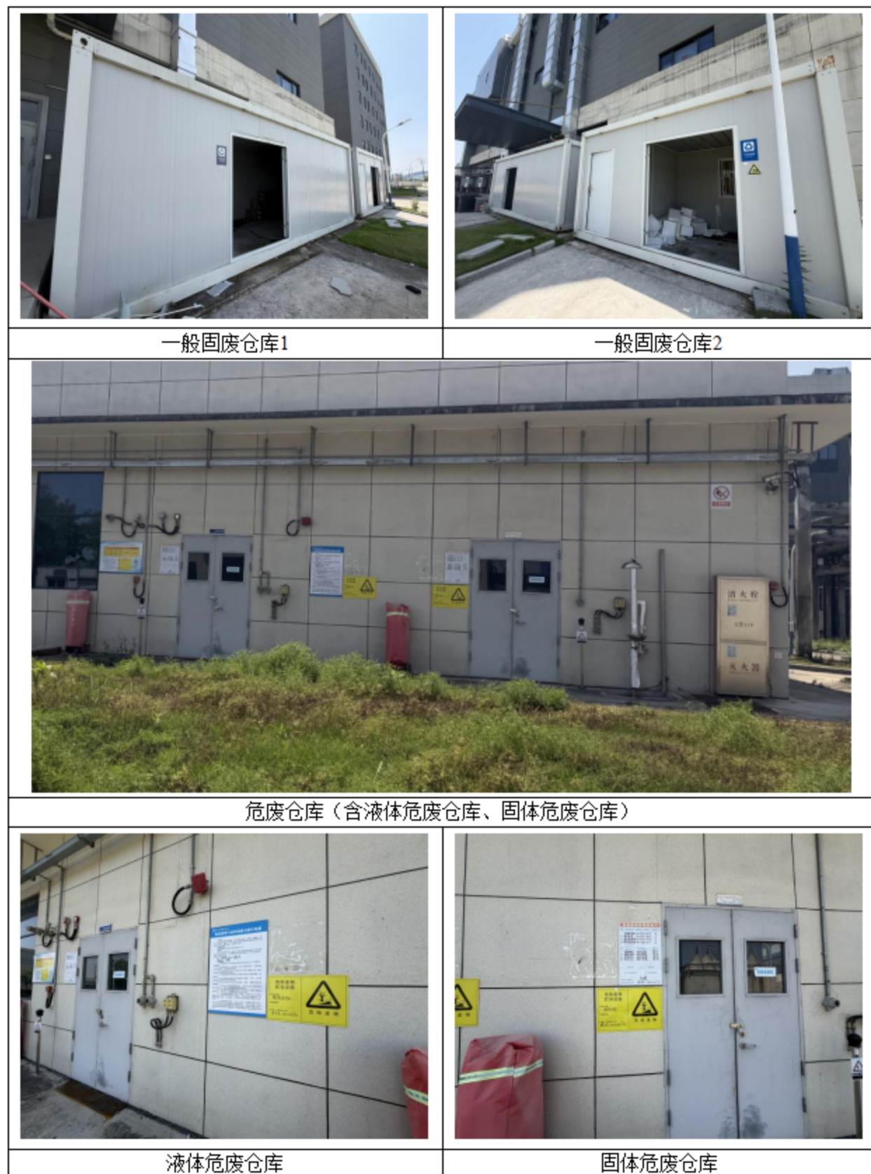
图3.3.5.3-1 二厂区现有固废暂存库现状照片
