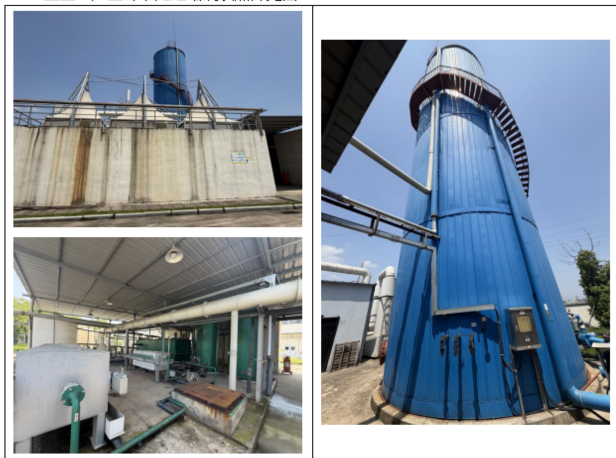
图3.3.5.2-3 二厂区污水处理站现状照片
